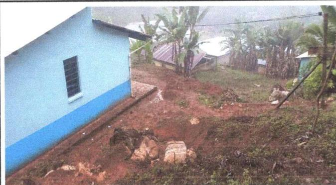
foto 3: Se observa derrumbe en el ancho de la escuela.
