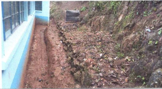
foto 1 :se observa la presencia de deslizamiento de tierra en la parte de atrás de la escuela.
