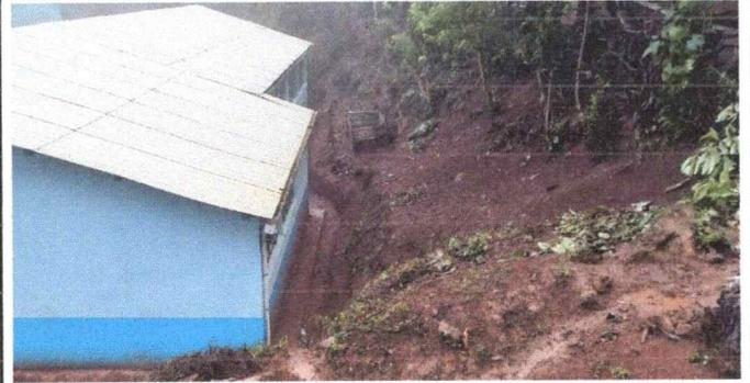
foto 2: se observa riesgo de delizamiento en el modulo 1
